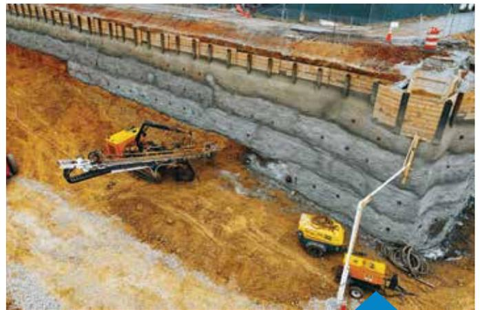
DRILLING UNDERWAY FOR SOIL NAILS.
